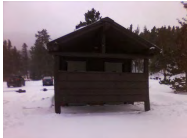
ROMO_31816_B-1059-N Vault Toilet, Sprague Lake_A.jpg
