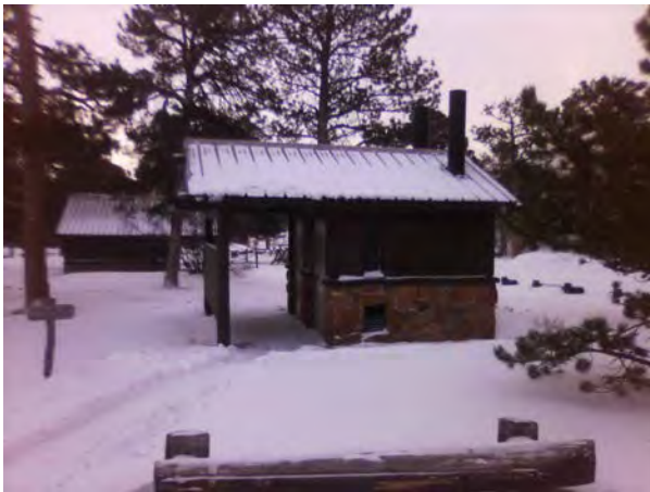
ROMO_31816_B-1059-N Vault Toilet, Sprague Lake_B.jpg
