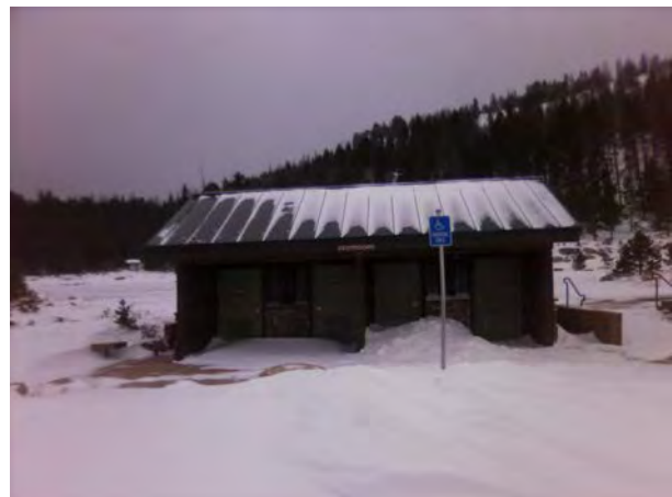
ROMO_82306_B-1119-N Vault Toilet Park & Ride_A.jpg
