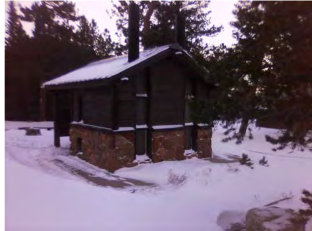
ROMO_31816_B-1059-N Vault Toilet, Sprague Lake_C.jpg
