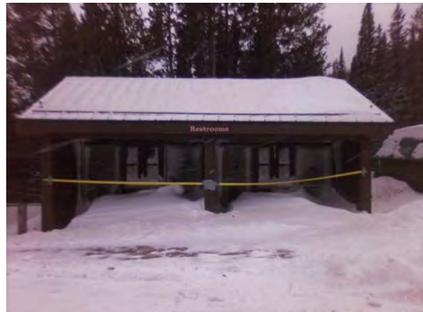
ROMO_82314_B-1126-N Vault Toilet Bear Lake West_A.jpg
