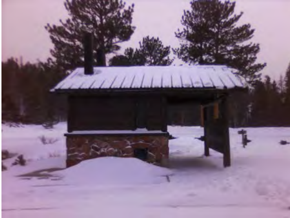
ROMO_31816_B-1059-N Vault Toilet, Sprague Lake_D.jpg
