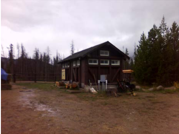
ROMO_17242_B-0572-H CRD Tack Shed_Front.jpg
