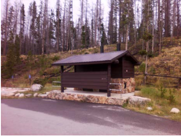
ROMO__B-1093-N Vault Toilet SST TCCG_Front.jpg
