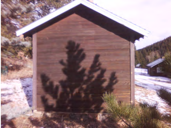
ROMO_25342_B-1010-H Pumphouse (Cabin)__D.jpg
