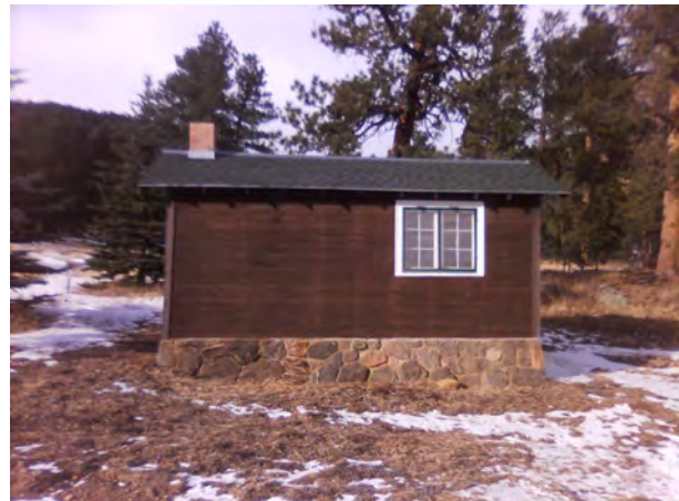
ROMO_25342_B-1010-H Pumphouse (Cabin)__A.jpg
